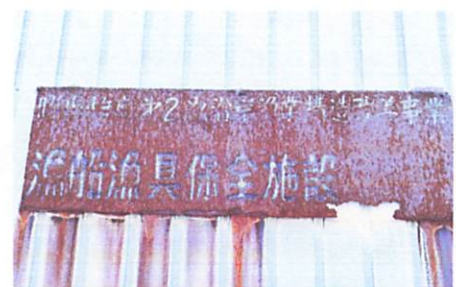
昭和 54 年度第 2 次沿岸漁業構造改善事業 漁船漁具保全施設
